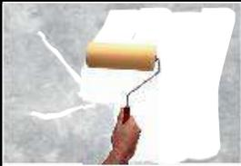
3: Aplicar BLOQUEADOR DE HUMEDAD , en filos de ventanas , partes bajas de paredes y cabezas de muro.
