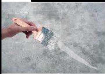
3: Aplicar pintura epóxica, MACROPOXI , con las especificaciones indicadas en ficha técnica .
