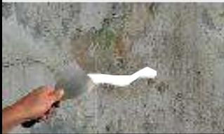
2: Corregir microfisuras y fisuras aplicando MASILLA ELASTOMÉRICA.
