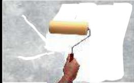
3: Aplicar BLOQUEADOR DE HUMEDAD , en fillos de ventanas , partes bajas de paredes y cabezas de muro.
