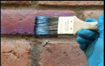
2: Aplicar 2 manos finas de recubrimiento impermeabilizante:
