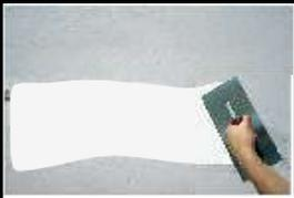
4: Si se requiere que la superficie quede completamente lisa se puede usar PROCRAFT EMPASTE DE INTERIOR o EXTERIOR según el caso
