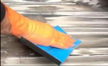
1: Eliminar polvo ,grasa , depósitos de óxido u otros contaminantes para que la superficie quede completamente limpia.
