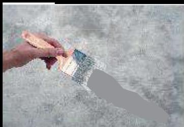
4: La aplicación puede ser con brocha ,rodillo o equipo Airless. Dependiendo del acabado y del producto a utilizarse.
