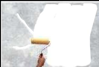
4: Aplicar 2 manos del recubrimiento IMPERMEABILIZANTE ELASTOMÉRICO PARA LOSAS en el color elegido.
