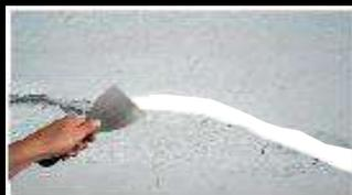
2: Corregir microfisuras y fisuras aplicando MASILLA ELASTOMÉRICA .
