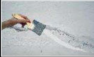
1: Realizar una limpieza de la superficie, para remover el polvo, smog y otros contaminates.
